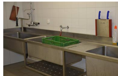
robuste Spültröge und Handwaschbecken, komplett in CNS gefertigt. Montiert auf Konsolen um eine optimale Reinigung zu ermöglichen.
